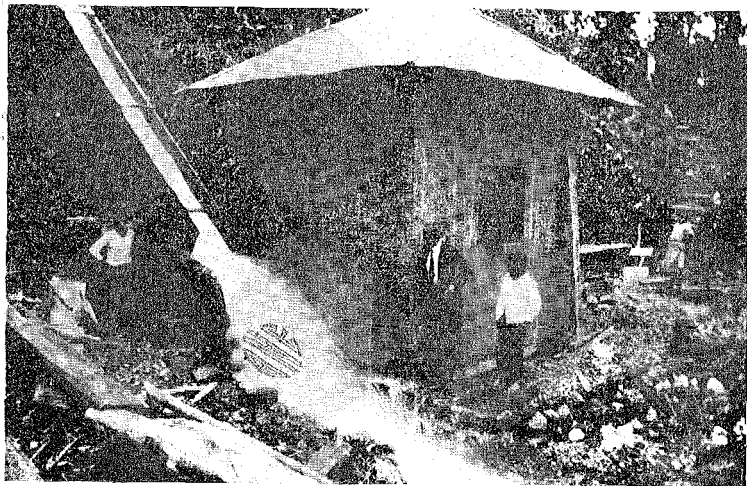
Vista panorámica de la caseta de la Planta Eléctrica de Mera, ubicada en el Río Chico
